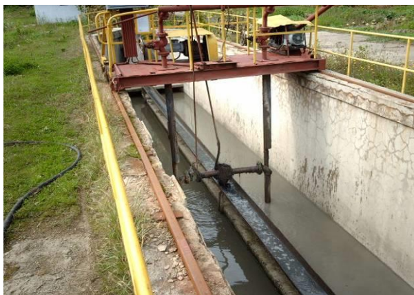
Figura Nr. 2-6 – Unitatea de îndepărtare a nisipului
