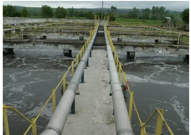
Figura Nr. 2-12 – Unitatea de sedimentare
