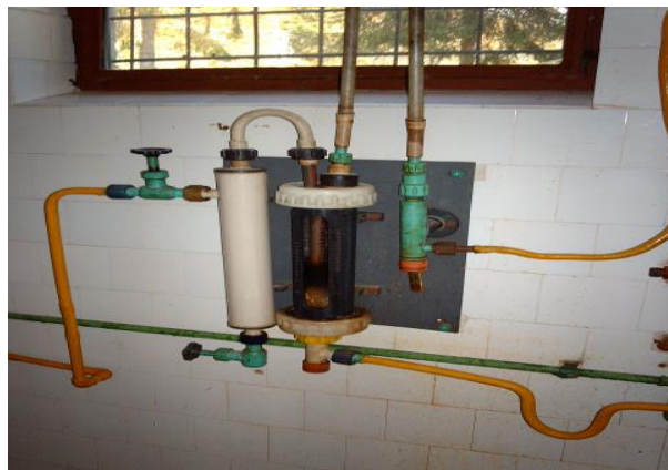
Figura Nr. 2-27 – Unitățile de filtrare din marmură Figura Nr. 2-28 – Instalația de clorurare
