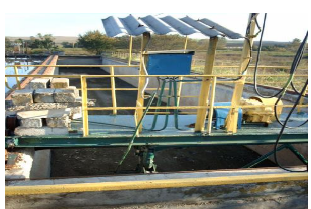
Figura Nr. 2-14 – Bazinul secundar de sedimentare
