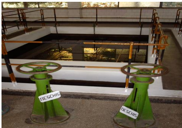
Figura Nr. 2-27 – Unitățile de filtrare din marmură Figura Nr. 2-28 – Instalația de clorurare
