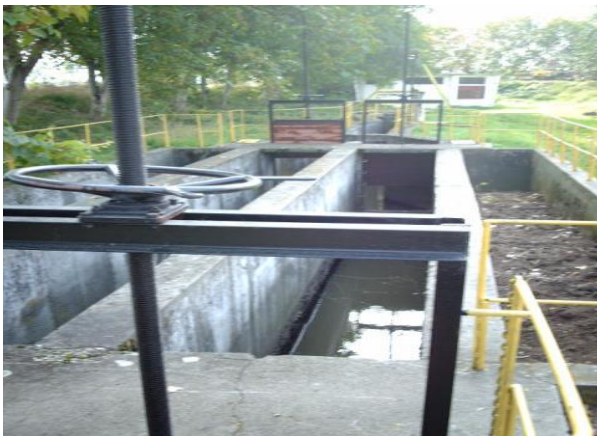
Figura Nr. 2-33 – Unitatea de îndepărtare nisip Figura Nr. 2-34 – Bazinul de aerare
