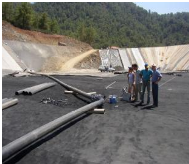
Figura 5-10: Constructia unui depozit de deseuri
