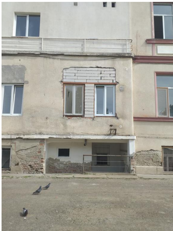
Degradari ale finisajelor interioare
