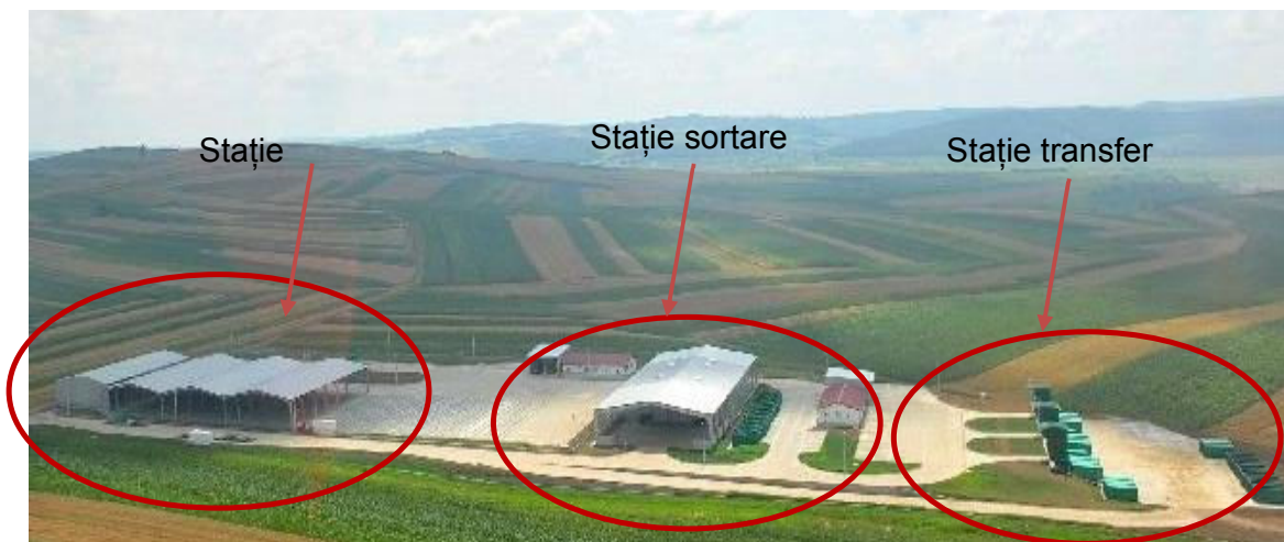
Figura 4.15. Stație transfer, sortare și compostare Cristești
