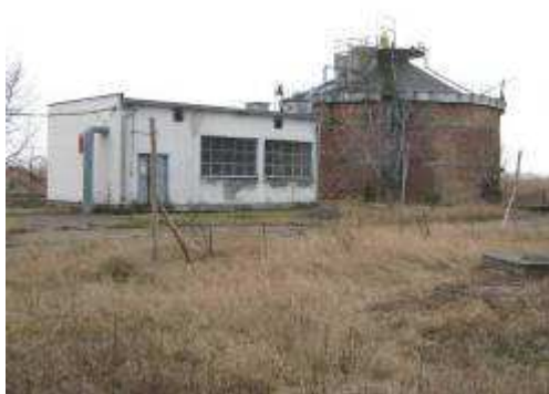
Figura 94 – Rezervor de fermentare a namolului SEAU Reghin
