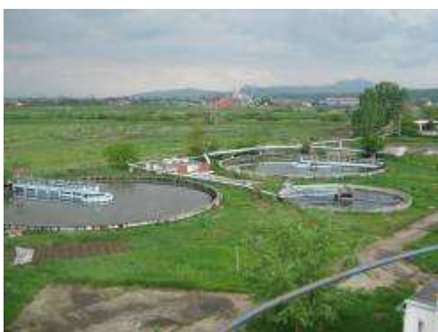
Figura 91 – Decantoare secundare linia noua SEAU Reghin
