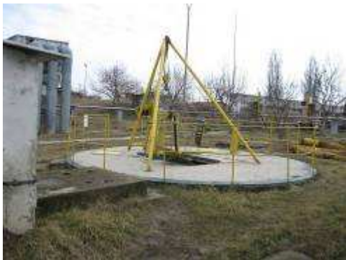
Figura 122 – Stație pompare nămol SEAU Tarnaveni
