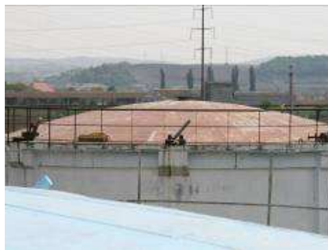
Figura 63 – Rezervoare de gaz 2 x 1000 mc SEAU
