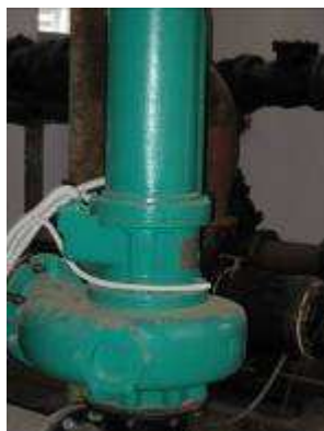
65 – Pompe recirculare namol tip Wilo SEAU Targu
