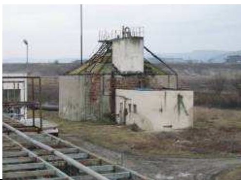
Figura 126 – Rezervor de fermentare nămol SEAU Tarnaveni
