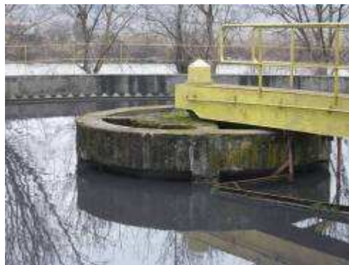
Figura 86 – Decantoare primare SEAU Reghin
