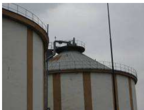
Figura 61 – Rezervoare de fermentare de 4000 mc SEAU Targu Mures
