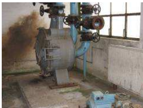
Figura 96 – Pompe recirculare namol SEAU Reghin
