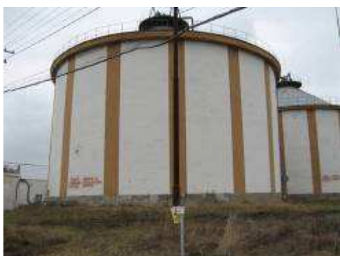
Figura 61 – Rezervoare de fermentare de 4000 mc SEAU Targu Mures
