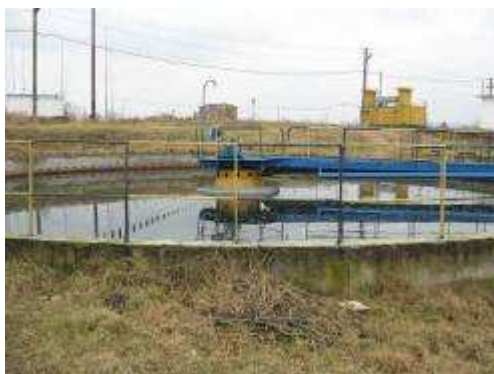
Figura 57 – Concentrator gravitacional de namol SEAU Targu Mures
