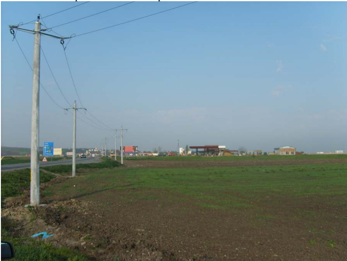
teren între E60-Aeroport și soseaua care duce la parc industrial
